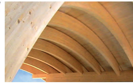
Rundbögen sind mit vorgefertigten BSH-Bauteilen schnell aufgebaut.
