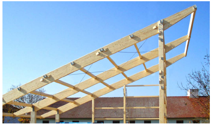
Beispiel: Basisversion S12 mit Pultdach – im Bau
